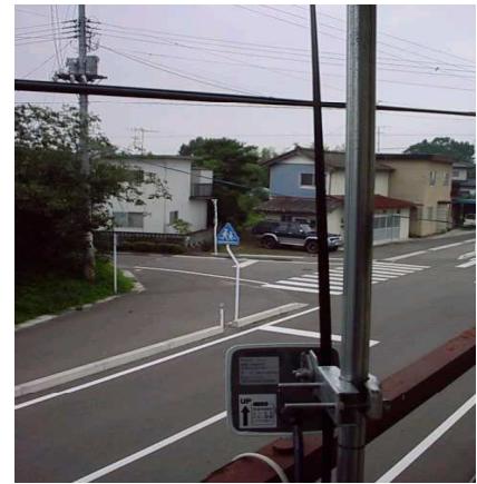
図2 無線LANのアンテナ
