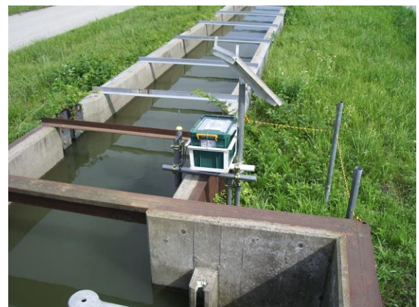
写真2 センサの設置風景（幹線用水路）
