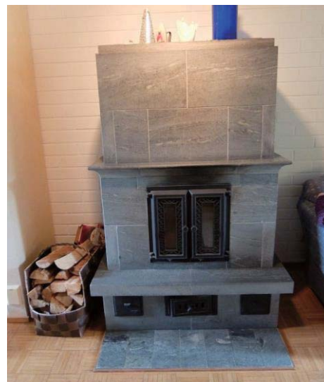
写真2 蓄熱量が多いとされる石材を用いた薪ストーブ
