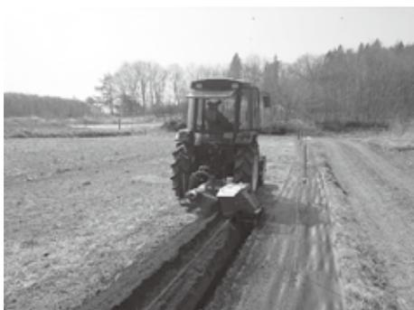
写真2 明渠施工
